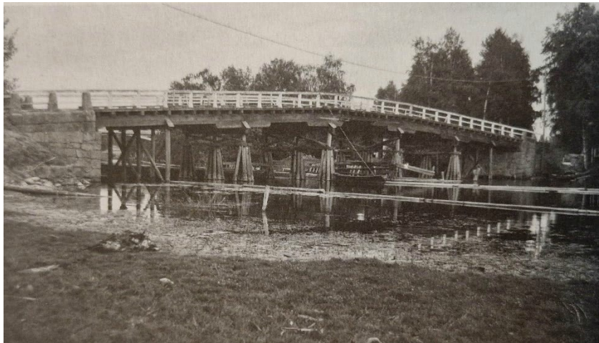
Kuva 9. Uusi silta Pappilanjoen suulla mahdollisti höyrylaivaliikenteen aloittamisen.
